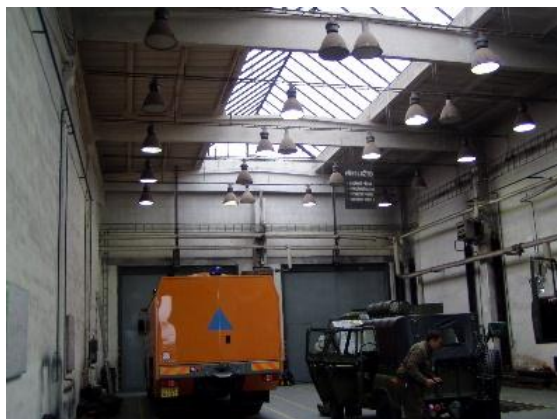
Stará výbojková svítidla část obj. č. 41
