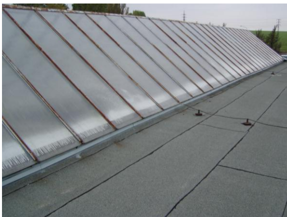
Ocelový světlík nad halovou částí (nad částí B)
