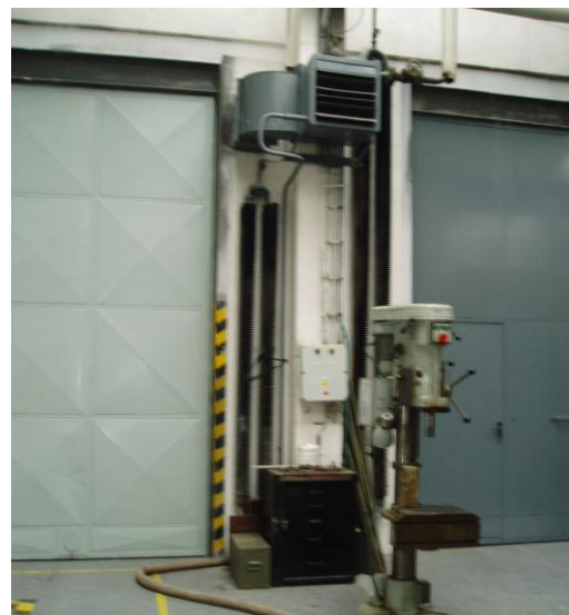
Registry a teplovzdušná souprava
