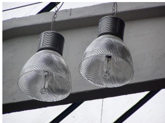
Nová výbojková svítidla část obj. č. 41
