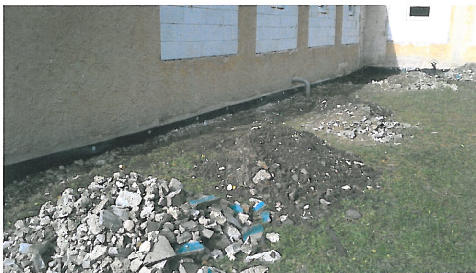
Obr. 3 Odkopání původní dlažby + zásyp a nová izolace
