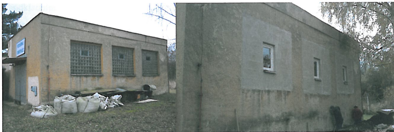
Obr. 1 Původní stav / nový stav (před štukováním)
