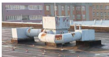
Axiální ventilátor pro společný odtah situovaný nad střechou
