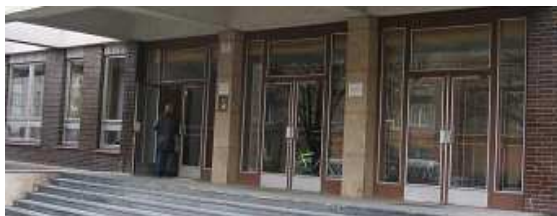
Vstupní dřevěné, prosklené dveře – ocelové, jednosklo
