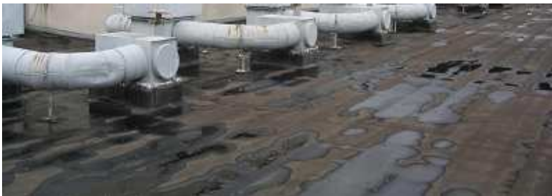
Osazení VZT na střešním plášti
