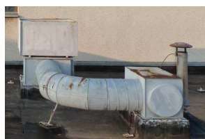
Axiální ventilátor pro společný odtah situovaný nad střechou
