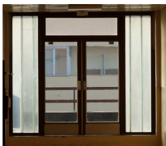
Kopilitové výplně s ocelovými dveřmi
