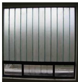
Copilitové výplně s ocelovými okny
