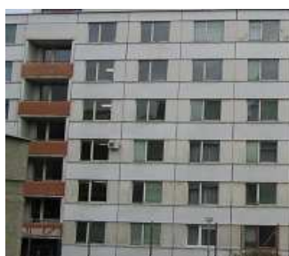
Původní výplně, dřevo, zdvojené zasklení
