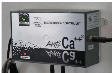
Dekalcifikátor na přívodu SV
