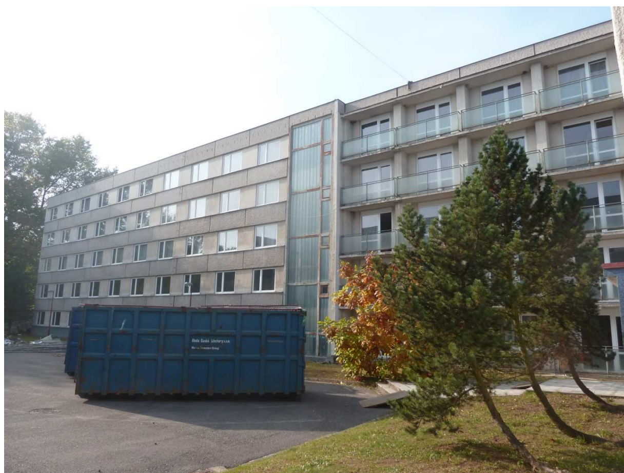
obrázek 30 SO 063 Budova ubytovaných – internát B
