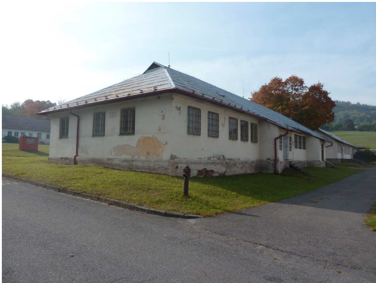
obrázek 13 SO 024 Budova pro skladování
