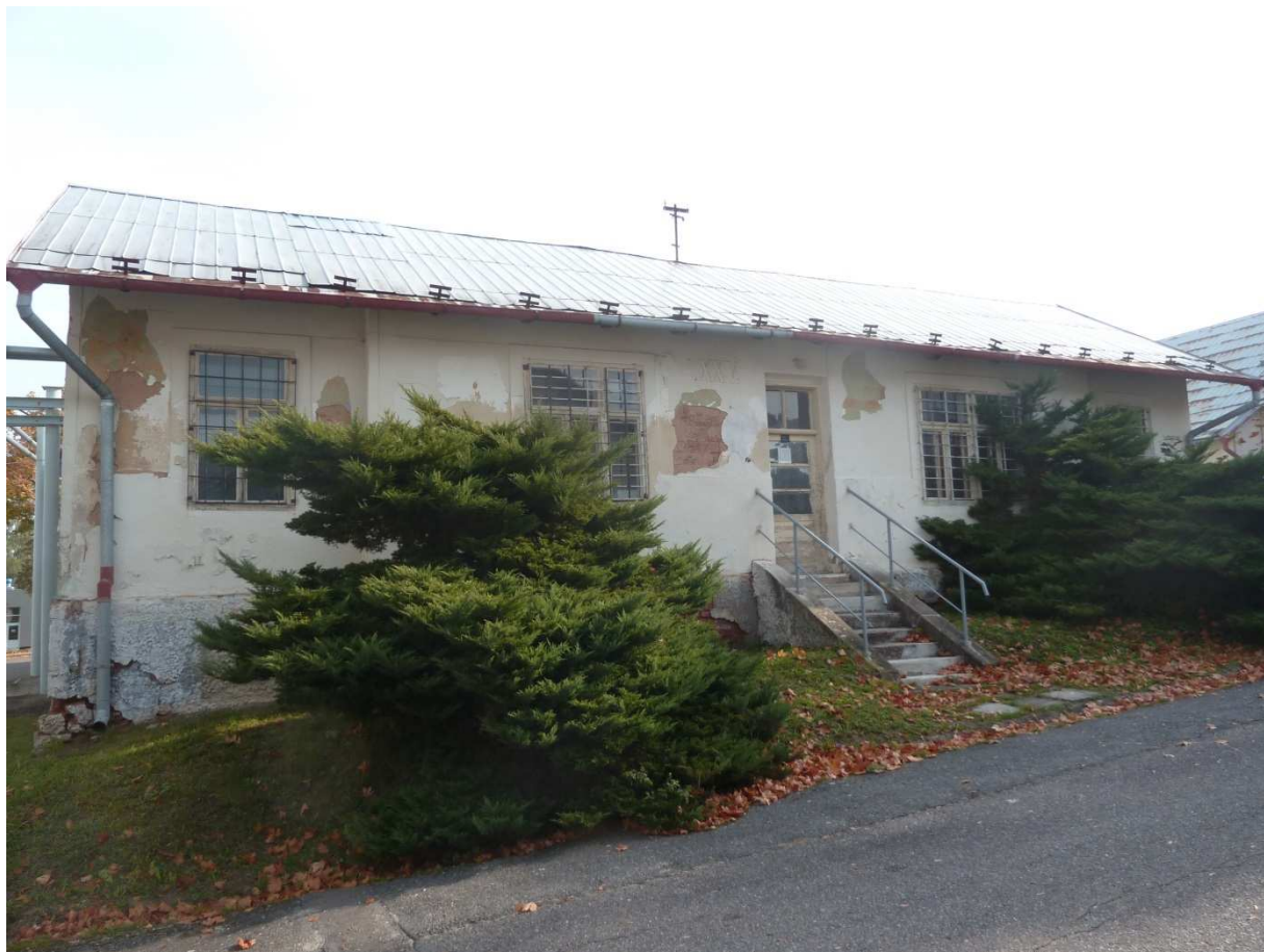
obrázek 16 SO 027 Budova pro skladování
