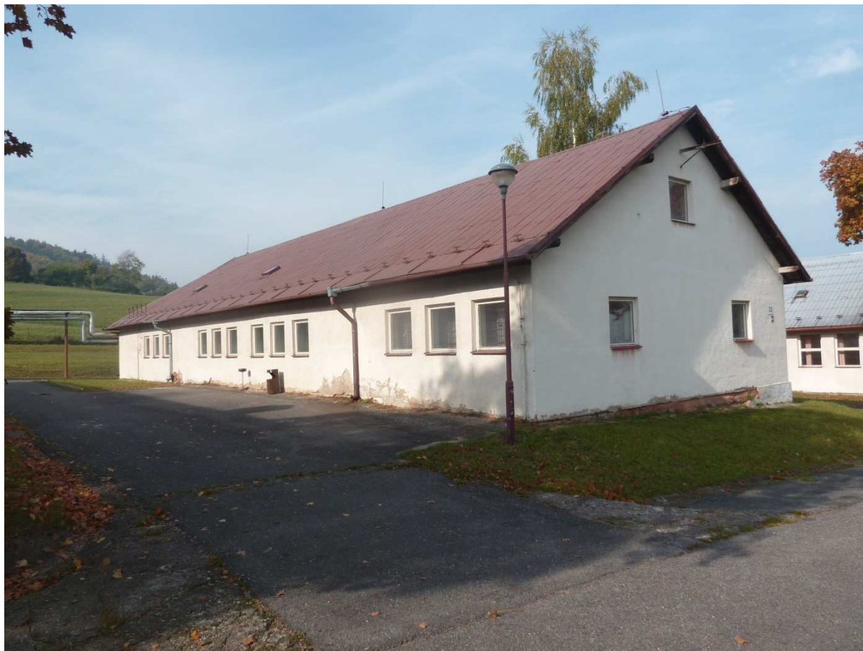
obrázek 12 SO 023 Budova pro skladování
