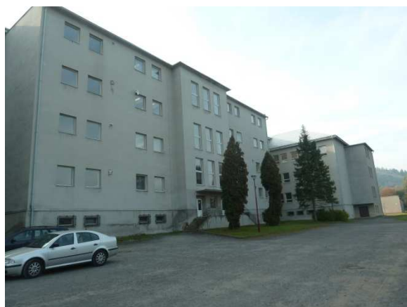
obrázek 7 SO 006 Budovy učeben
