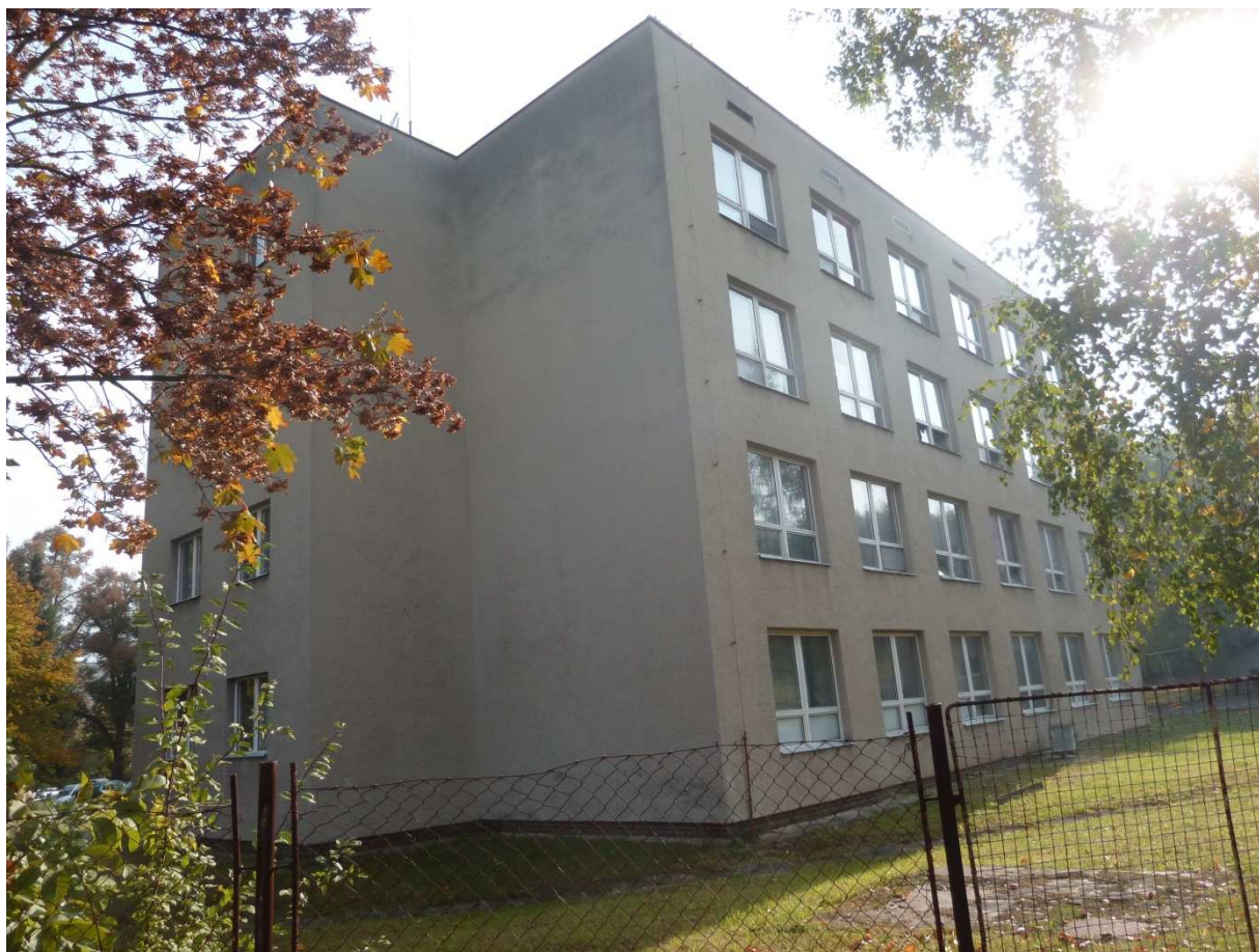
obrázek 31 SO 066 Budova ubytovaných
