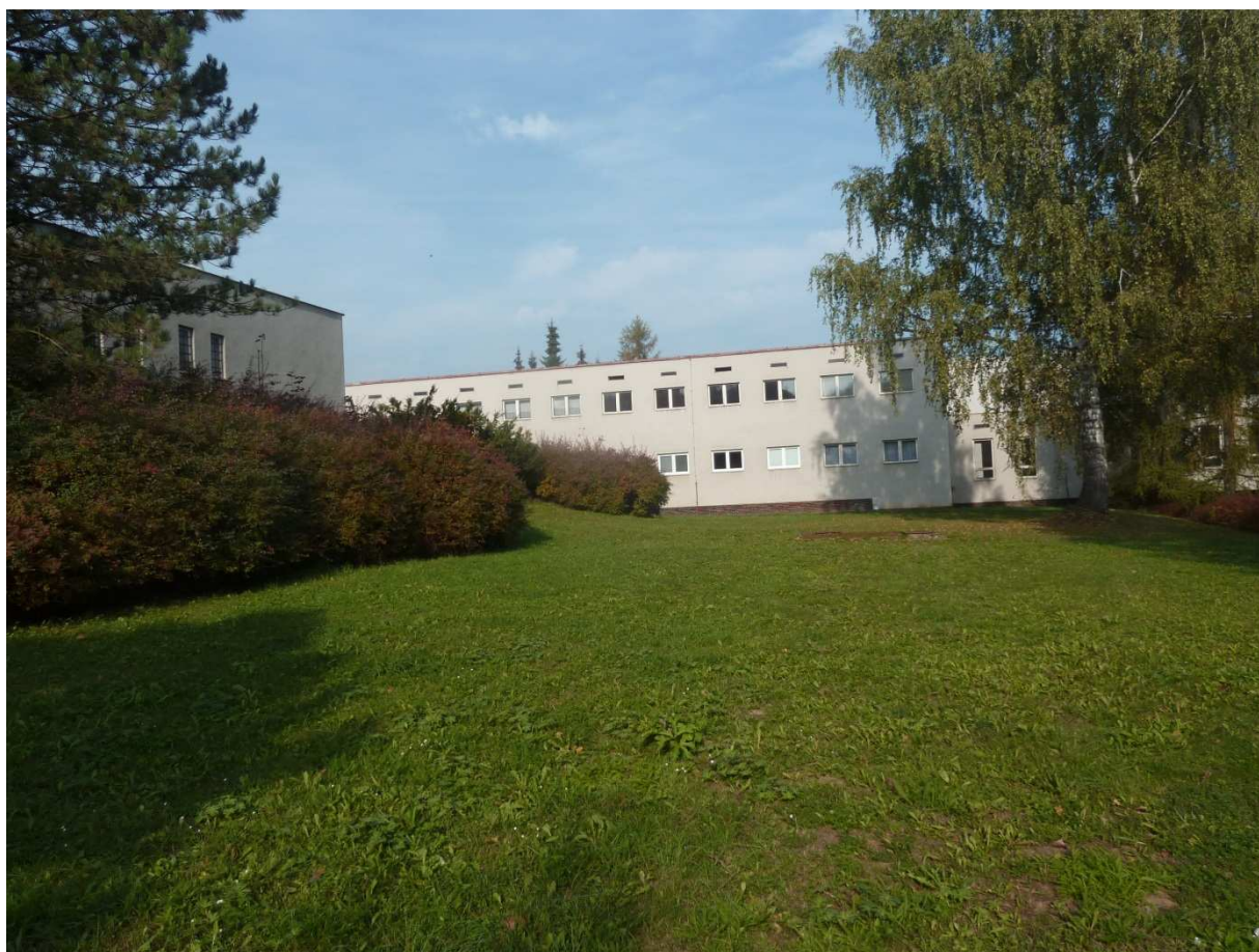
obrázek 36 SO 072 Budova pro výuku a výchovu
