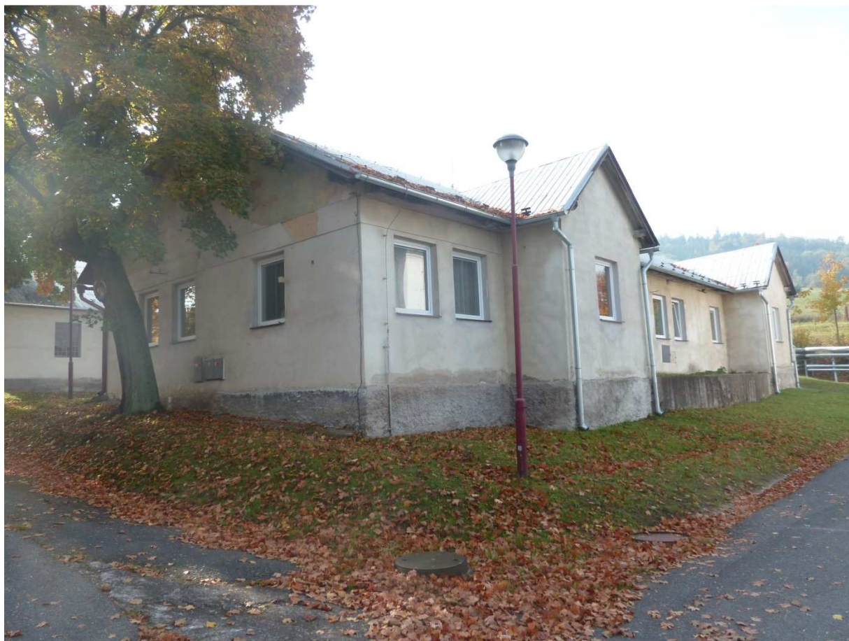
obrázek 21 SO 032 Budova administrativní
