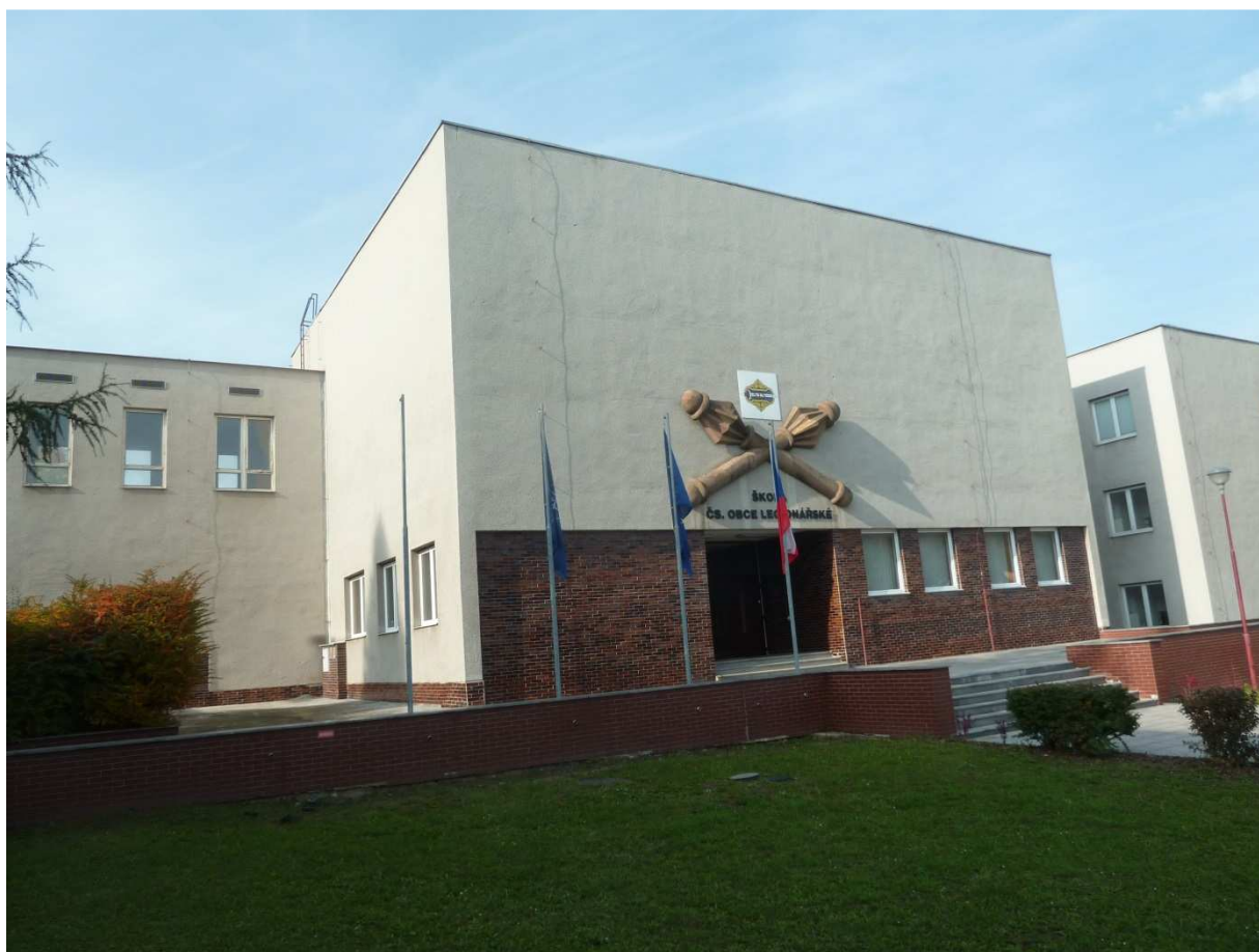
obrázek 35 SO 071 Budova administrativní
