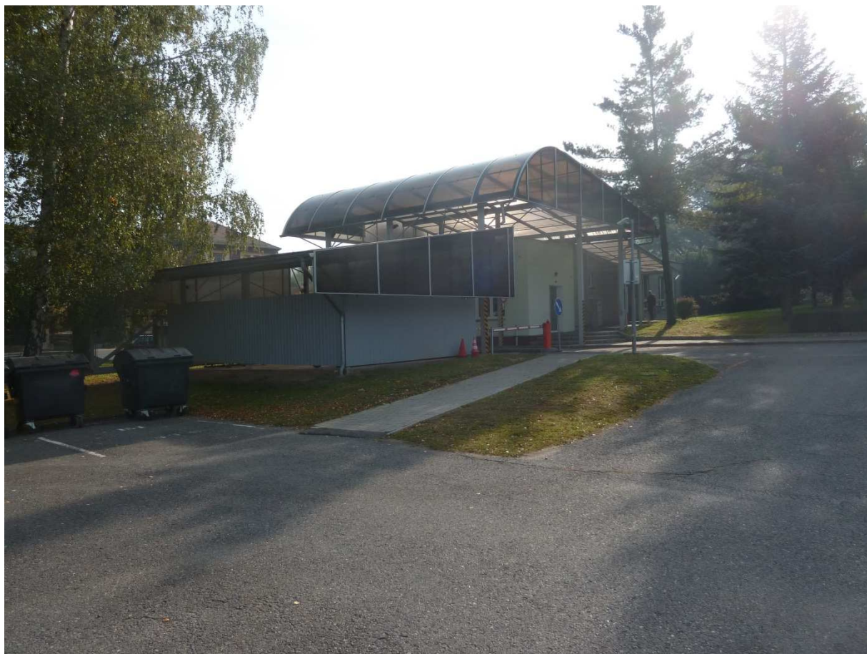
obrázek 27 SO 060 Budova vrátnice, strážnice
