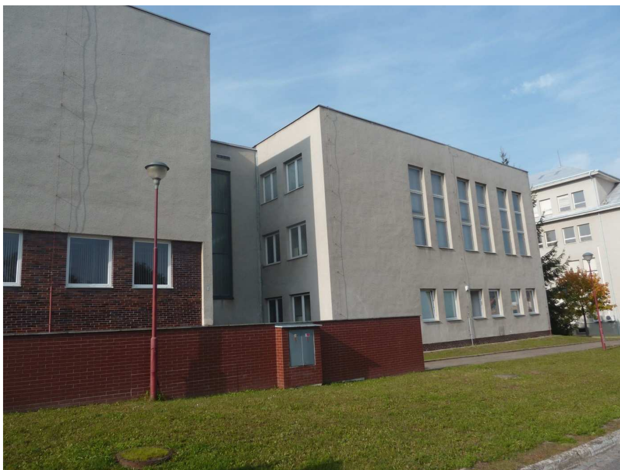
obrázek 34 SO 070 Budova administrativní
