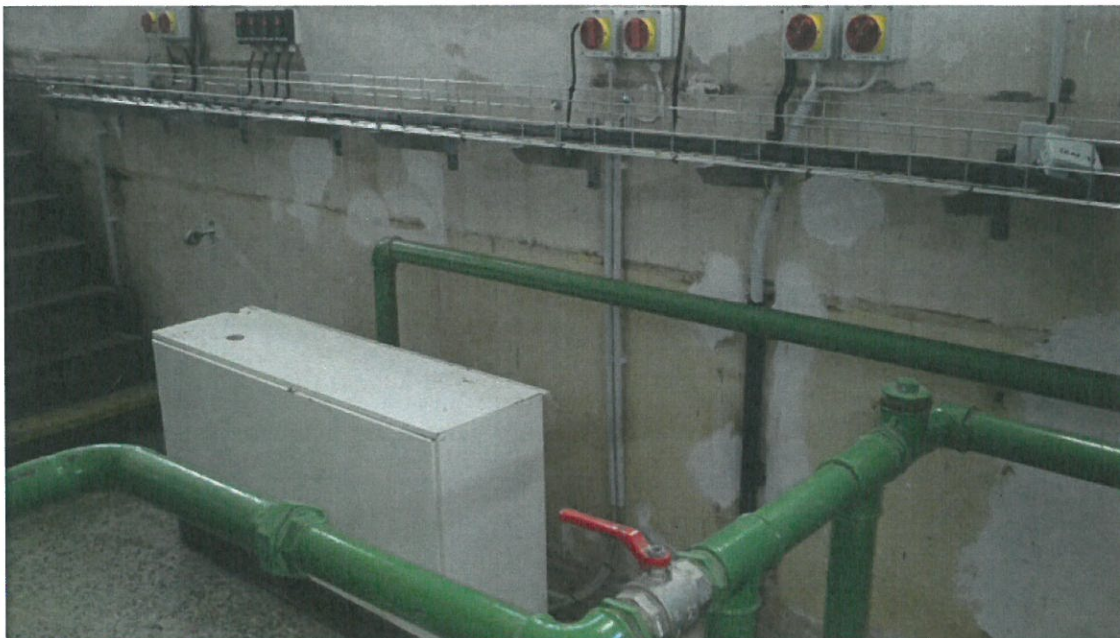
Obr. 2 Připojení akumulčních kamen
