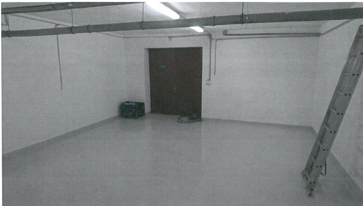
Pohled na uhelnu – stav po realizaci
