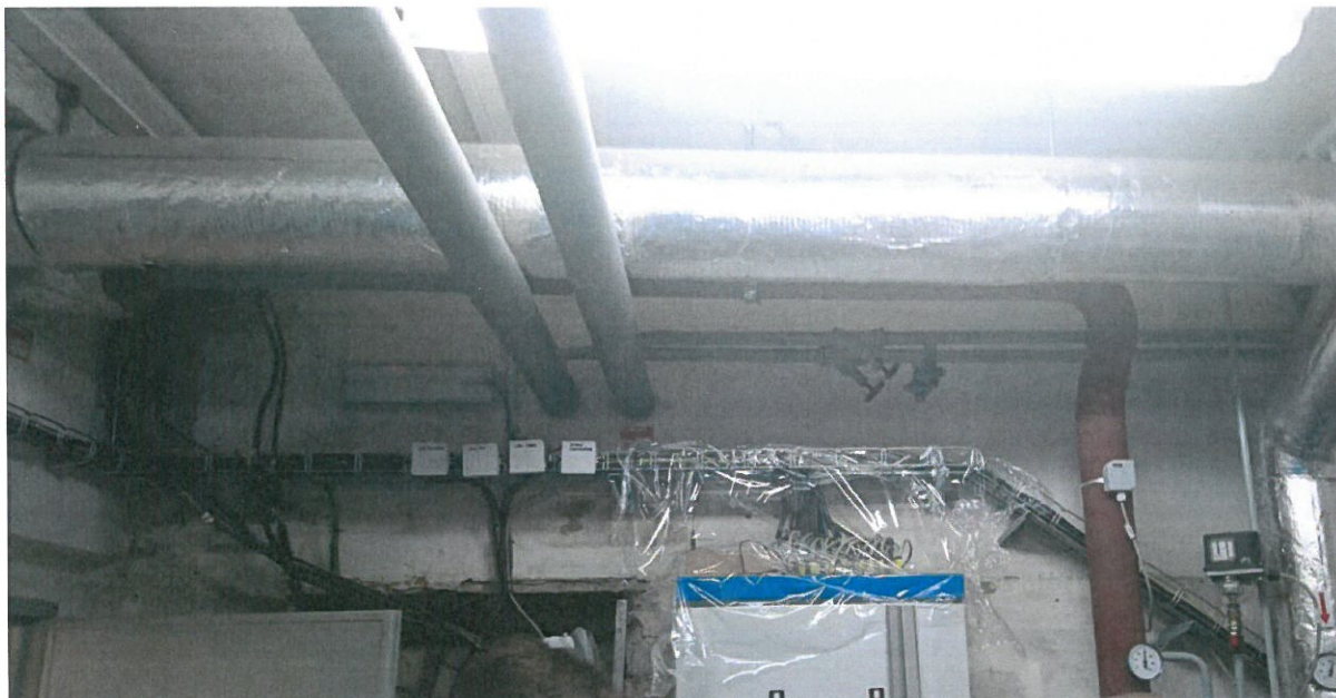
Pohled na úpravu vyvedených kabelů – stav v průběhu realizace
