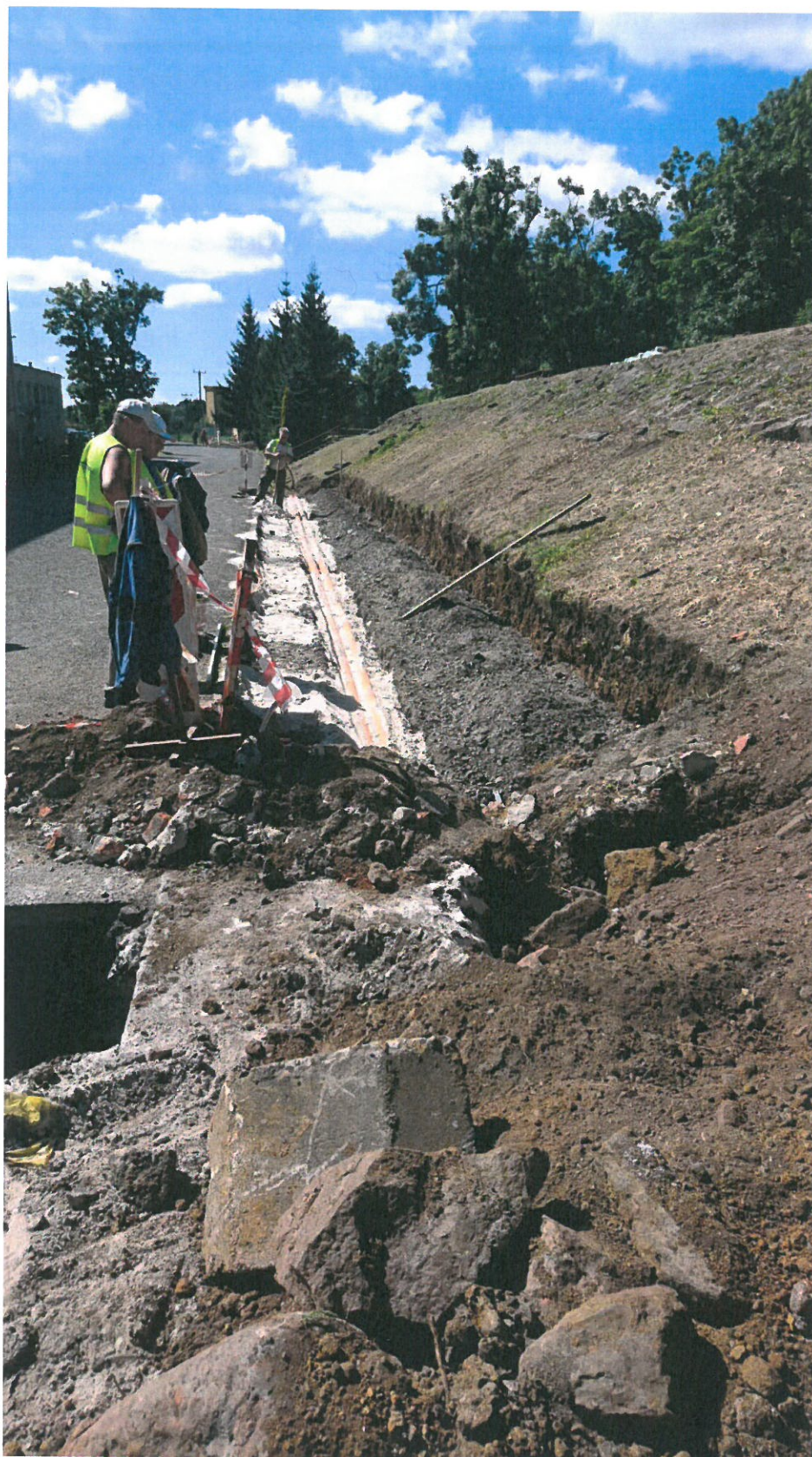
Pohled na budoucí stáčecí místo – stav při výstavbě
