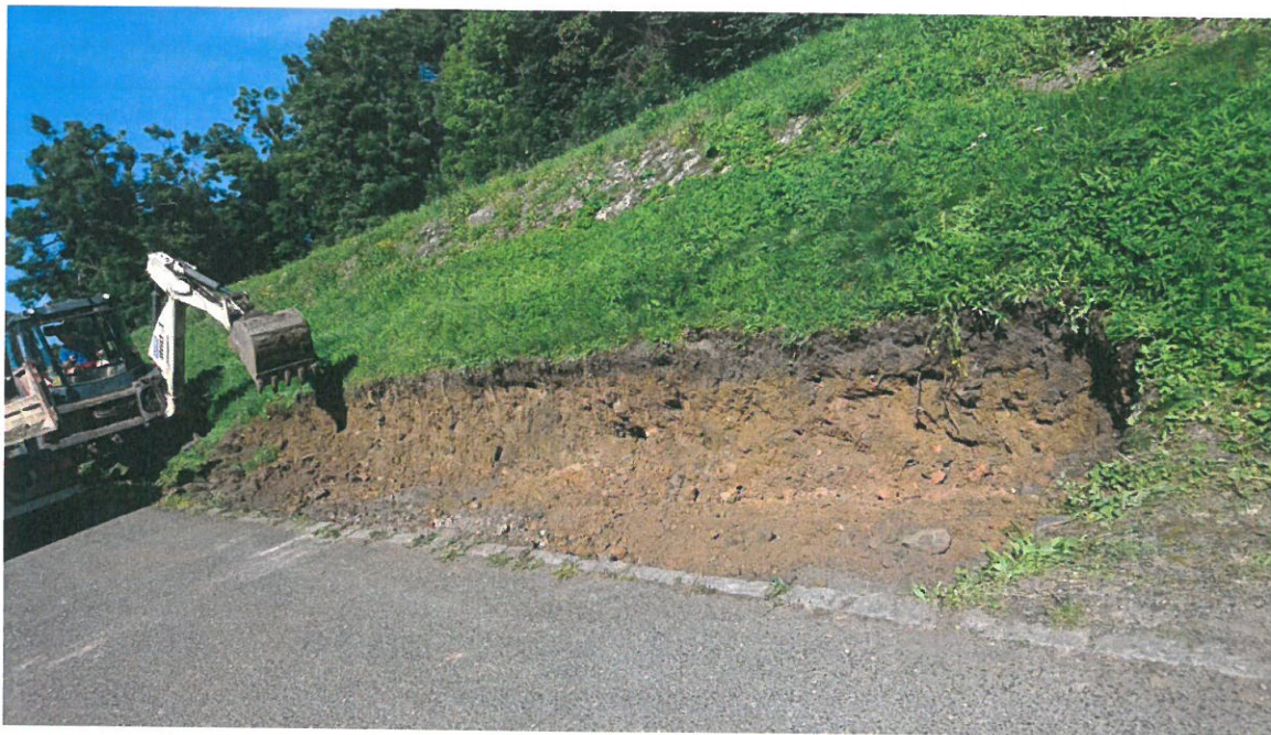
Pohled na budoucí stáčecí místo – stav při výstavbě, pohled od silnice
