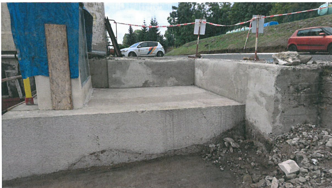
Pohled na „přístup“ k HUPu - pohled zespoda
