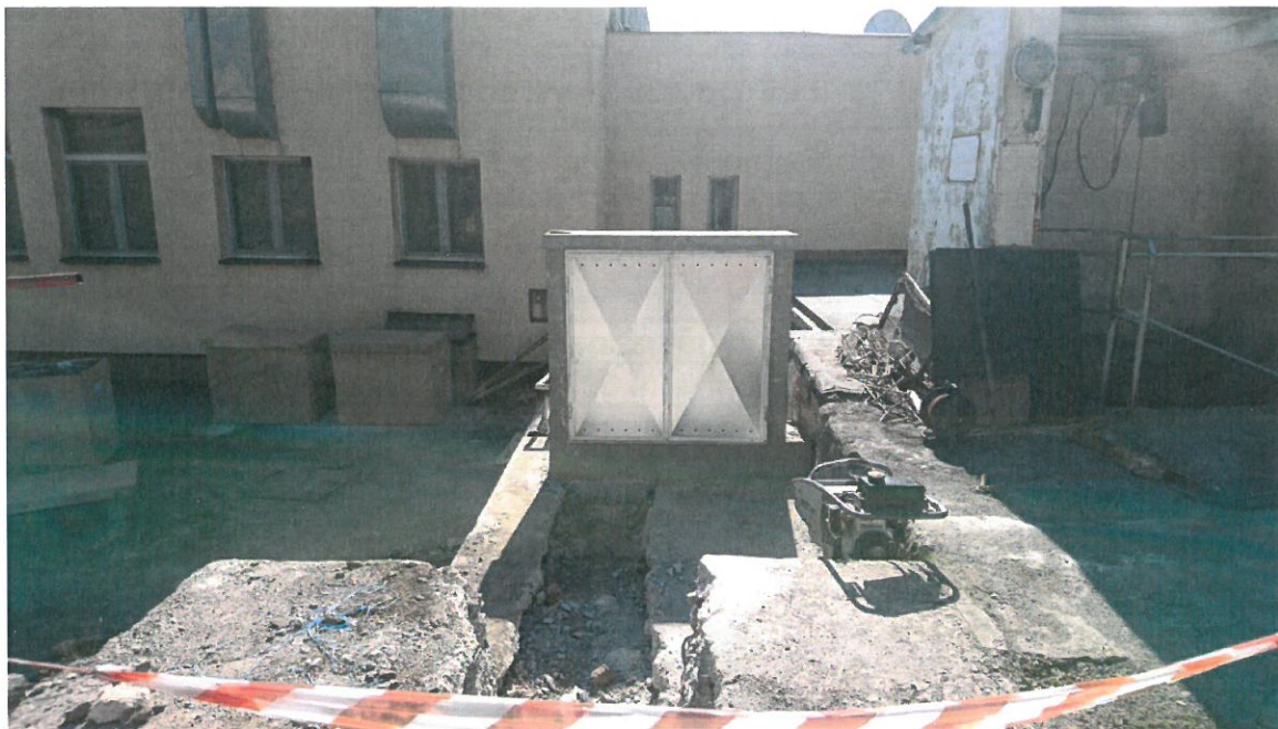
Pohled na HUP – stav při výstavbě, pohled od silnice
