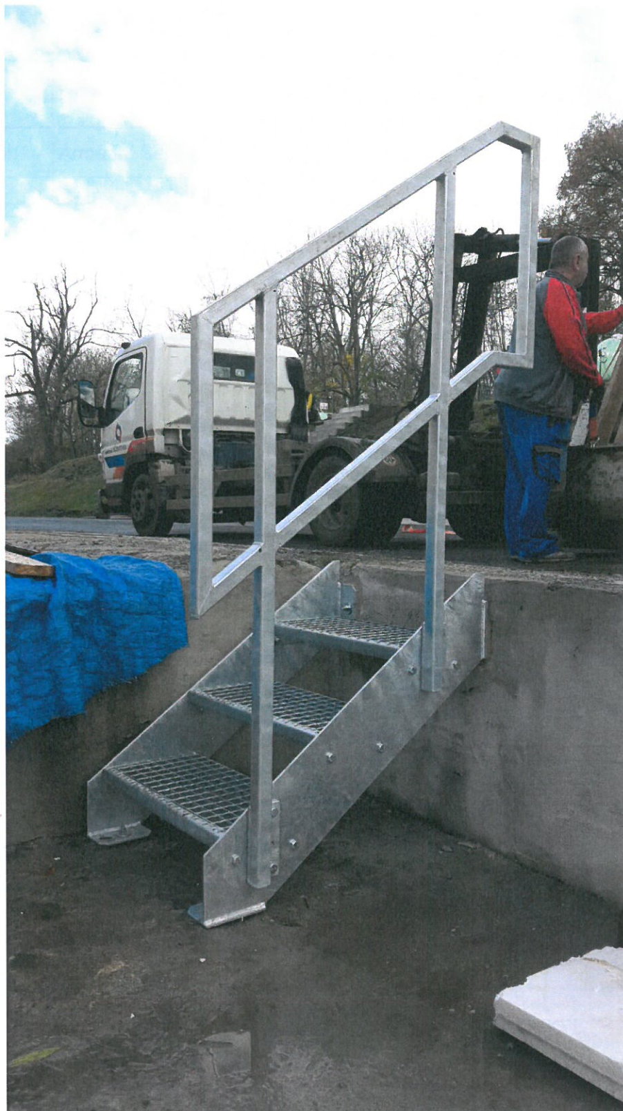
Pohled schodiště pro přístup k HUP – stav po realizaci
