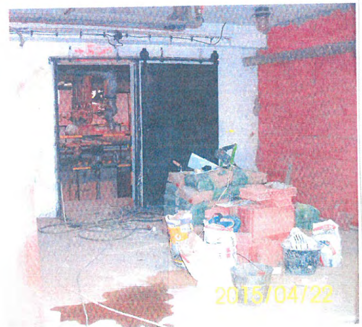
VÝROVNĚNÍ PODLAHY VE VELNĚ PO REALIZACI
