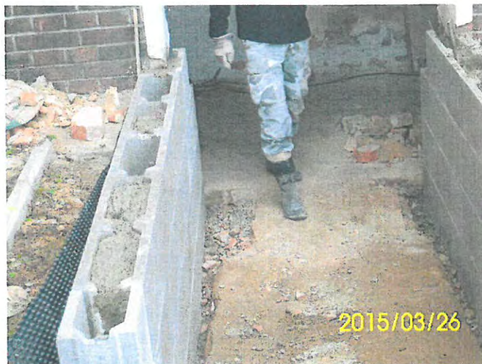
Foto realizace SO 001 - venkovní schodiště
