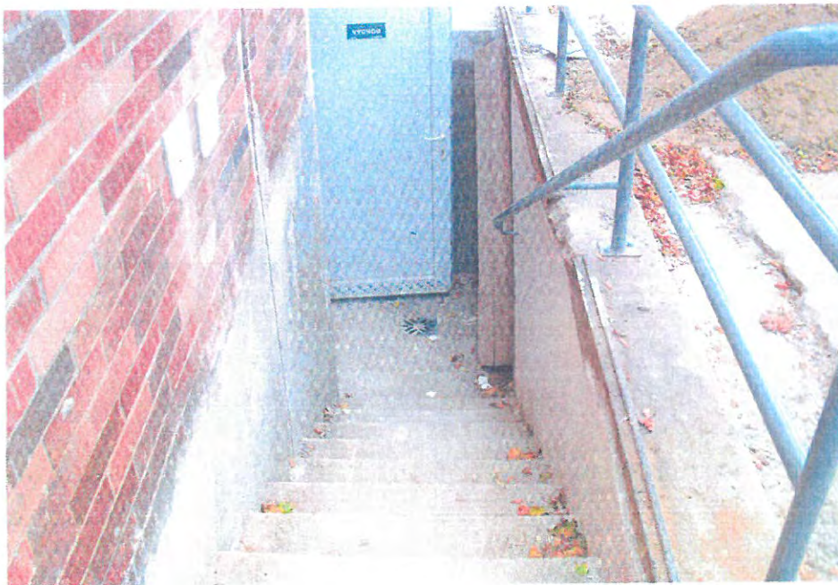
VSTUP. SCHODIŠTĚ DO VEHY - PO REALIZACI
