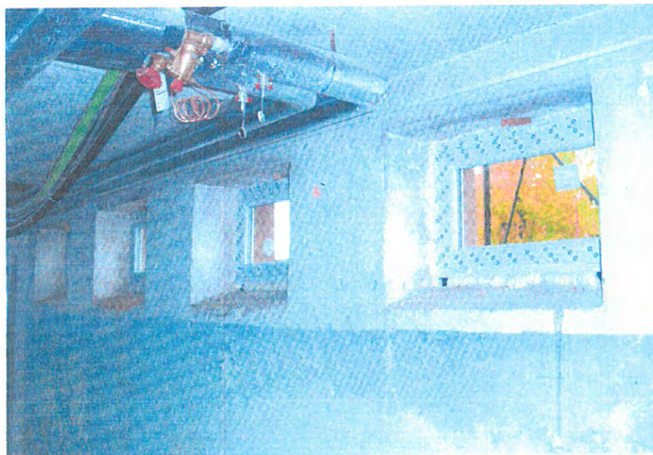
VYMĚNĚNA OKNA - P4
